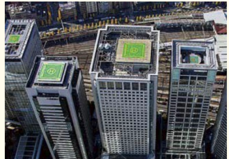
ビル屋上の緊急離着陸場 (出典はエアロファシリティ(株)のHP)
