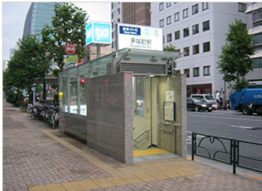
建て替えて実現した完全防水型出入り口 通常時(上)と閉扉時(下)
