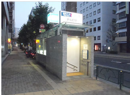
建て替えて実現した完全防水型出入り口 通常時(上)と閉扉時(下)
