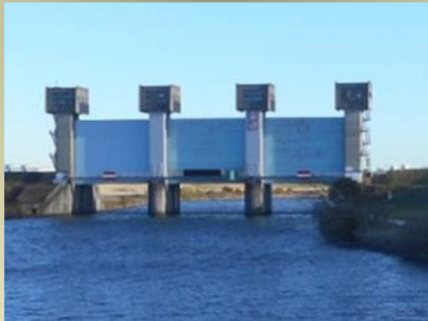
荒川と隅田川の分流点にある岩淵水門 (出典は、国交省関東地方整備局荒川上流河川事務所のHP)
