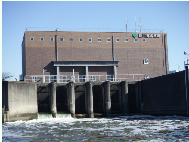
排水能力6t/sの新川排水機場 (出典は東京都建設局のHP)
