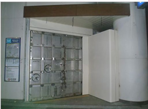
既存構造を利用した完全防水型出入り口 通常時(上)と閉扉時(下)
