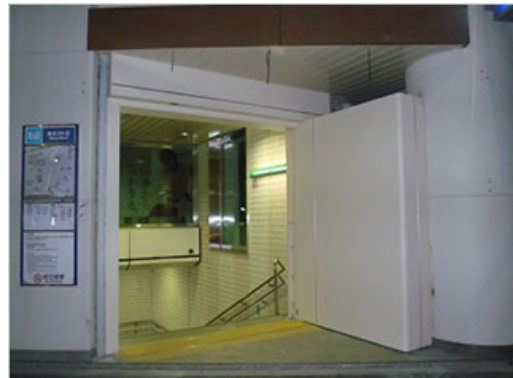
既存構造を利用した完全防水型出入り口 通常時(上)と閉扉時(下)
